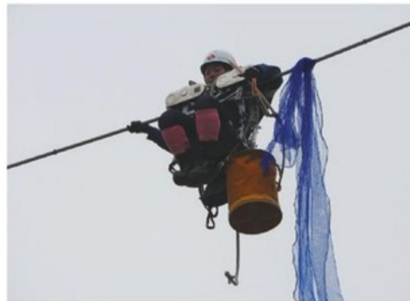
電線の保守作業
